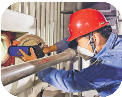
点检工对锅炉管道进行查漏。王怀摄
