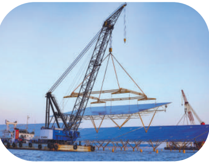
光伏板吊装作业。袁静雯 王加帅摄
