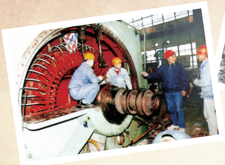
焦作电厂员工对老机组进行检修。
