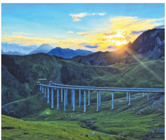
果子沟大桥——全国首座公路双塔双索面钢桁斜拉桥。王会英摄(湖南永州公司)
