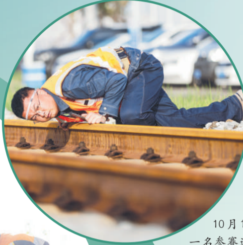
10月14日，接触网工接触网承力索卡绝缘项目比赛现场，一名参赛选手正在全神贯注地安装接触网承力索卡绝缘设备，每一个动作都体现出空中作业的精湛技艺与专业功底。 孙欢腾 摄（铁路装备）
