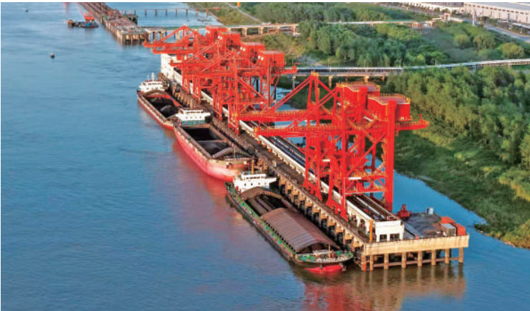
▲ 无人卸船机精准运行抓斗，从万吨江轮上抓取煤炭，整个作业过程平稳有序。 许海军 摄
