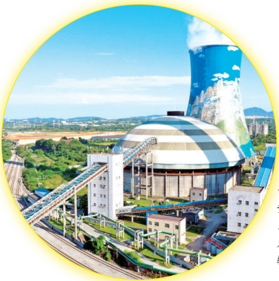
▲ 封闭式气垫输煤皮带系统实现煤炭全过程绿色输送与存储。 熊清 摄
