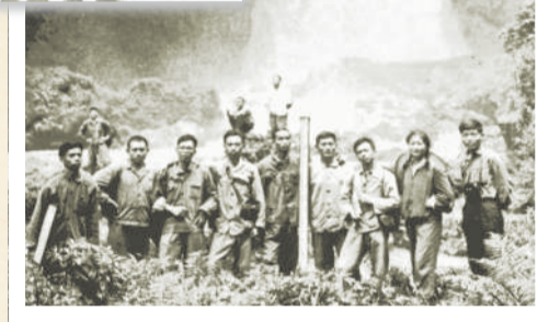
▶ 1958年6月,建设人员在红枫电站施工现场。
