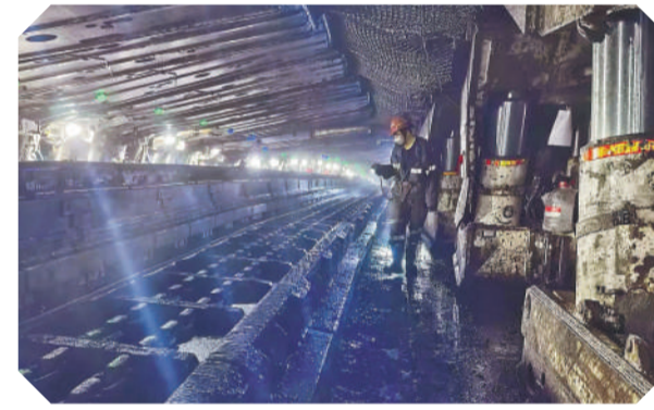
布尔台煤矿12202综采工作面贯通现场。
