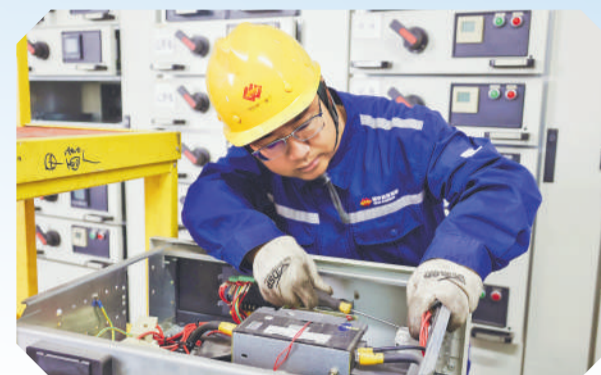
DCS控制柜安装现场。
