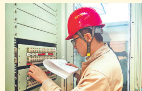
职工在检查核对线路保护压板投退状态。
