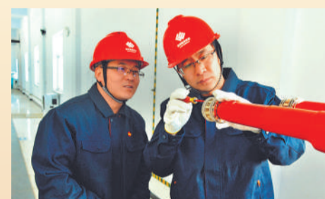
风电场检修人员对开关小车进行维修。
