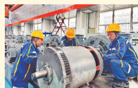
修旧利废小组正在整修备品电机。
