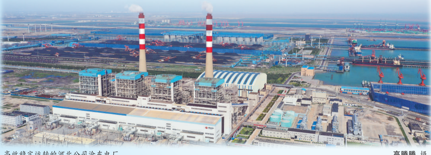
高效稳定运转的河北公司沧东电厂。
