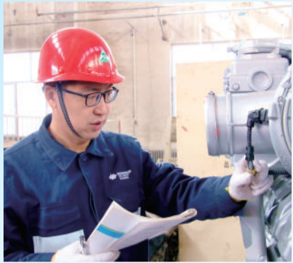
平庄煤业元露天矿开展安全隐患大排查。通讯员 付泽 摄
