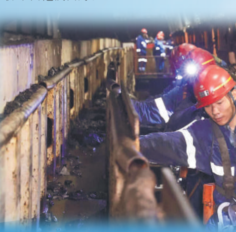
班组成员正在协力搬运检修所需配件。
