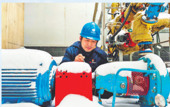
▲ 近日，河北邯郸地区突降大雪，河北公司邯郸电厂主动出击，加强设备巡回检查维护工作，进一步消除各类缺陷隐患，保障迎峰度冬期间电热稳定供应。图为检修人员冒雪检查氧化风机电机。 通讯员 薛娇娇 摄
