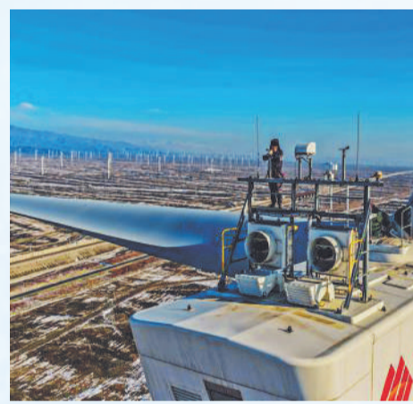
▲ 1月中旬以来，新疆地区遭遇强寒潮天气，气温骤降超20摄氏度，给电力设备安全稳定运行带来严峻挑战。新疆电力龙源新能源制定差异化防寒防冻措施，组织运维人员重点对风电机组齿轮箱油位、叶片、塔筒等关键部位进行细致排查。特巡人员借助望远镜、红外测温仪对线路、设备进行逐段巡视，及时清理设备积雪，保障风机线路畅通。因为该公司达坂城风电二场员工正在检查风速仪。 通讯员 陈伟 谷佳蔚 摄
