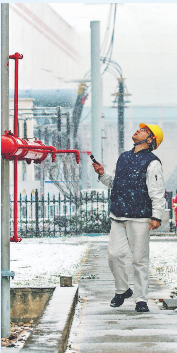
▲ 面对强冷空气和大面积雨雪冰冻天气，江苏谏壁公司迅速启动极端天气应急保供预案，以“保安全、保发电、保供热”为核心目标，多措并举落实防寒防冻措施，全力保障电力、热力可靠供应，发挥区域重要电源支撑点作用。
