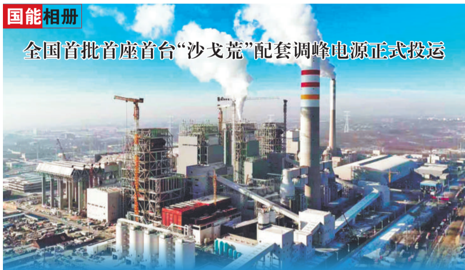
1月29日,宁夏电力中卫电厂4号机组顺利通过试运行,标志着全国首批首座首台“沙戈荒”能源大基地配套调峰电源4×660兆瓦扩建工程首台机组正式转入商业运营。图为中卫电厂4×660兆瓦扩建工程全貌。通讯员 李梦圆 田芮 摄
