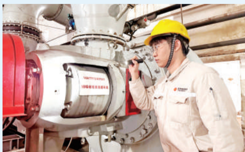
工作人员对吸收塔浆液循环泵进行检查。
