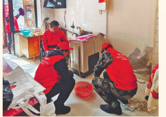
▲ 3月2日,龙源新能源培训中心志愿服务队走进伊春市伊美区北郡社区,为残疾人送去慰问品,切实解决生活难题。图为志愿者在帮助整理家务和粉刷破损墙面。 朱跃辉(龙源新能源培训中心)
