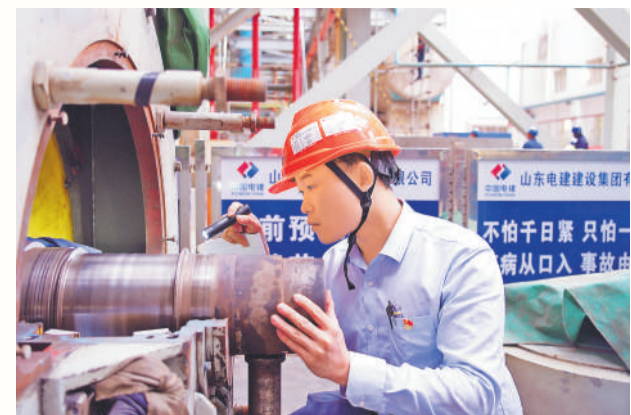
电气专业人员对风机电机进行解体检查。陈敏龙 摄
