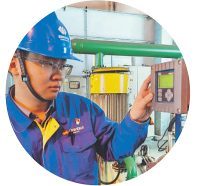
窦之翔正在操作输煤栈桥煤泥水循环系统。
