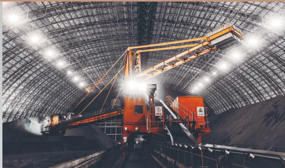
安徽公司铜陵电厂封闭煤场。
