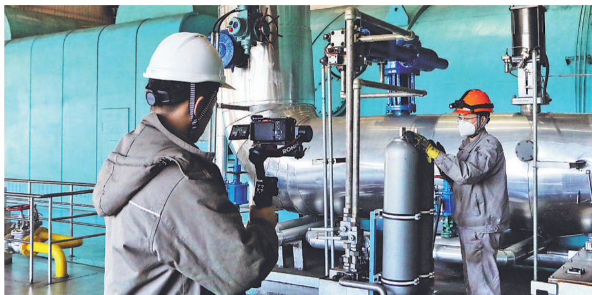
▲ 3月10日，辽宁沈西厂新闻宣传人员孙寅轩(左)深入设备检修现场，用镜头聚焦一线检修人员，真实记录检修人员精益求精、实干担当的画面。
