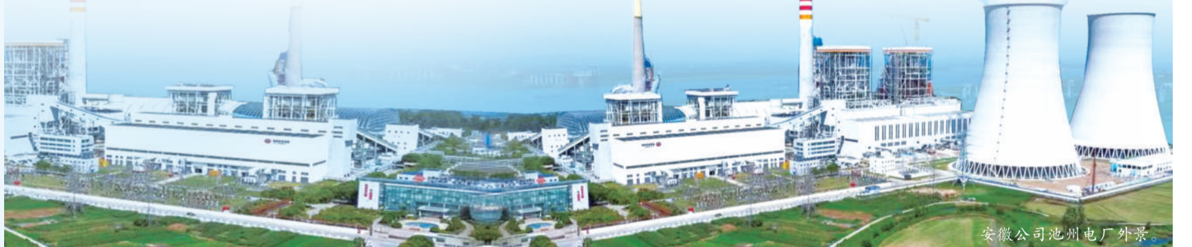
安徽公司池州电厂外景。
