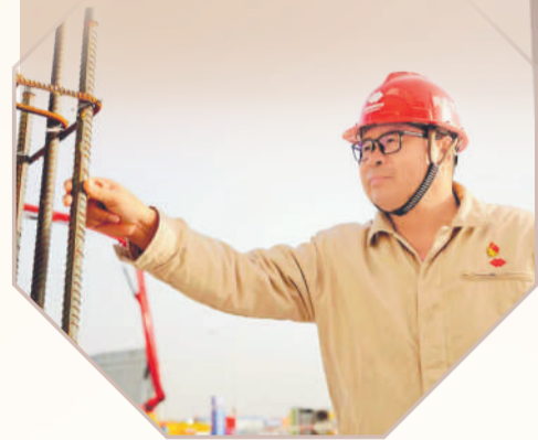
工作人员现场检查混凝土钢筋质量。
