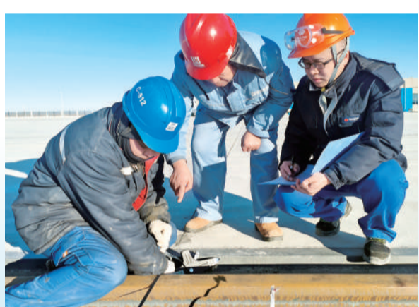
▲ 哈密能源切实将事故警示要求转化为实干行动,筑牢年后开工及项目安全生产双重防线。图为该公司集成创新基地项目现场大件组焊厂房外,施工人员开展室外轨道检查验收及测量对中作业。 包智斌 摄
