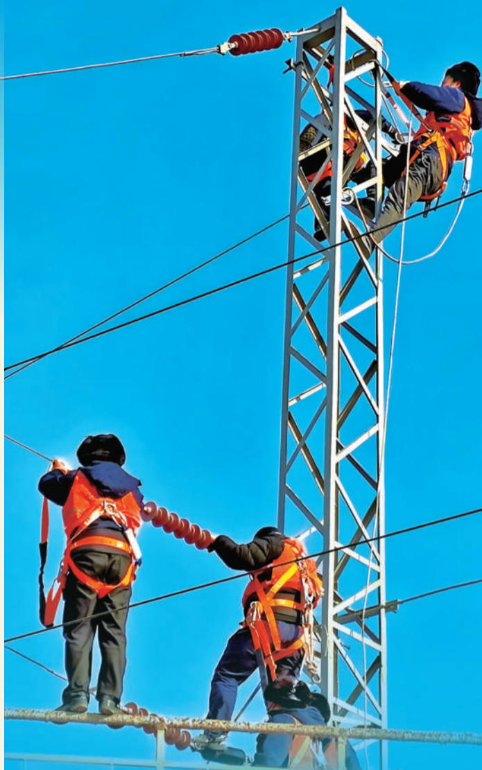
▲ 朔黄铁路黄大公司以隐患排查为抓手,强化“事前预防”管理能力,严格按照相关判定标准全面排查各类隐患,对一般隐患立行立改,较大隐患制定长效措施,确保隐患彻底消除。图为该公司供电专业网电工利用网电车及人工登杆的方式,对站场设备进行精检细修。 李博 摄
