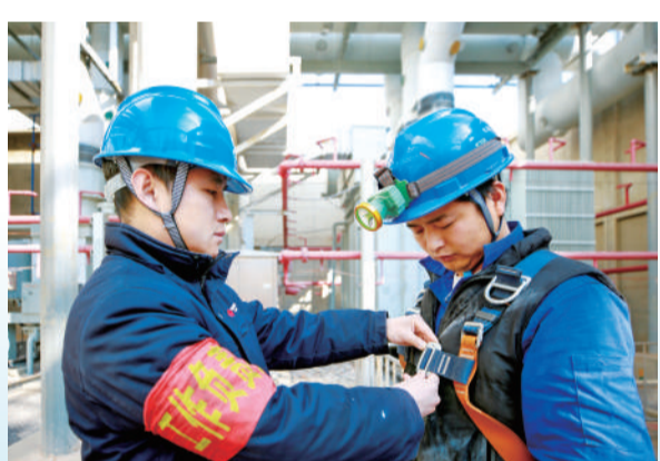
▲ 在“事故警示月”活动中,河北公司定州电厂以现场安全大检查为抓手,推进安全环保各项工作落实落地。图为该厂1C检修现场,工作负责人正在检查高空作业人员安全带佩戴情况。 李永杰 摄
