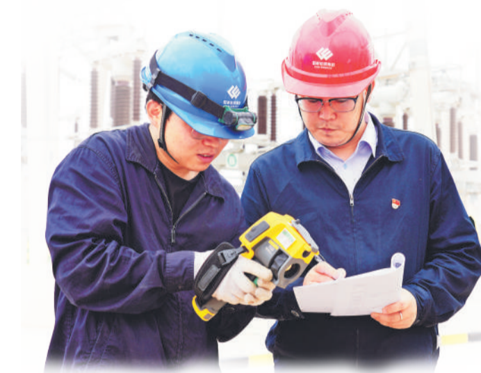
班组运维人员正在记录升压站红外测温仪数据。
