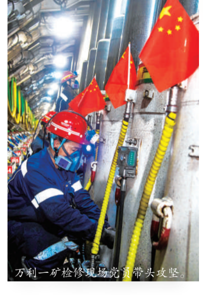
万利一矿检修现场党员带头攻坚。
