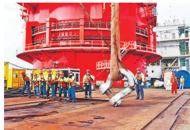
▲ 2025年12月6日，龙源电力启源海风场开展海上升压站吊装前作业准备工作。赵乐川 摄
