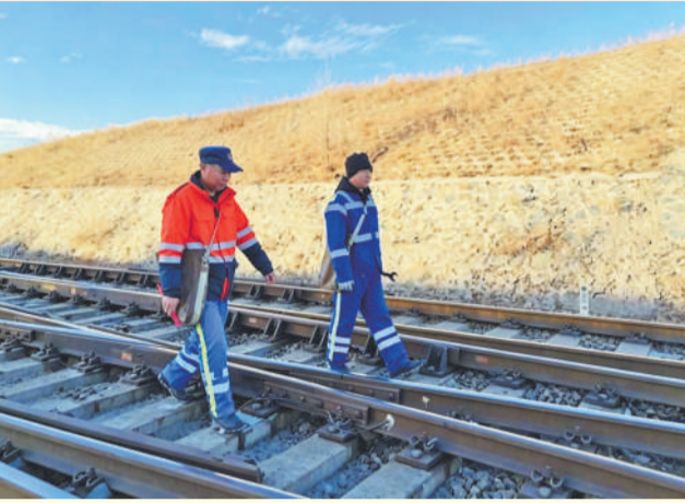
员工们正在巡检道岔。
