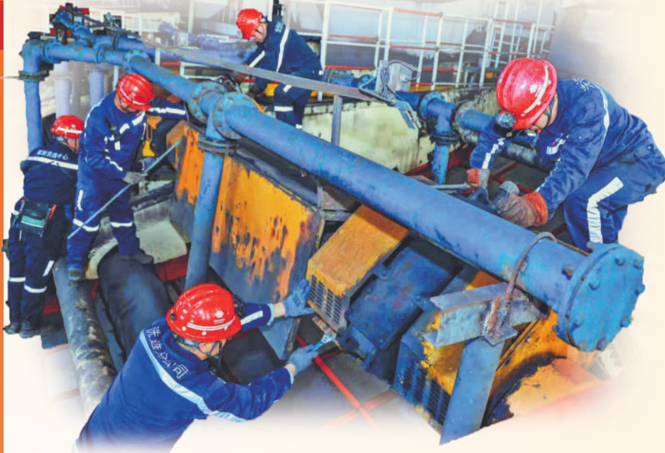
包头能源煤炭洗选分公司职工正在进行振动筛激振器防护罩加装作业。
