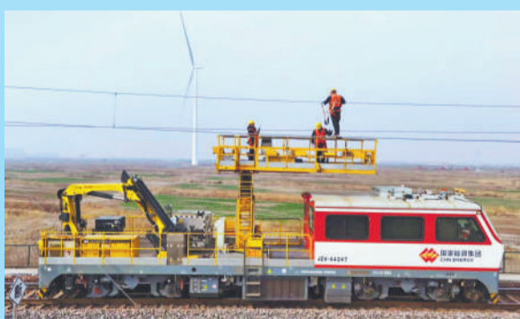
作业人员乘轨道车进行接触网平台巡检。周萌摄
