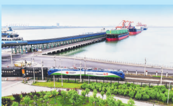
朔黄铁路万吨列车卸车后驶过黄骅港环线。孟鑫摄
