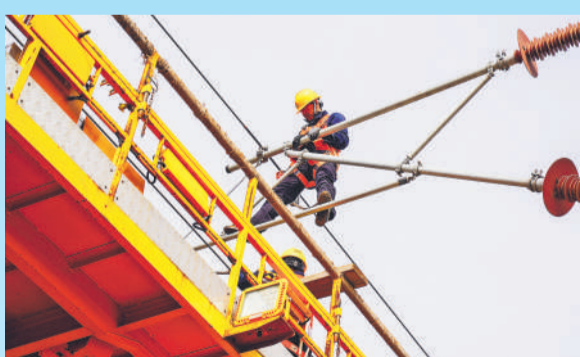
工务人员有序开展接触网检修作业。刘志远摄
