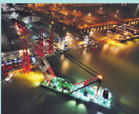
罗源湾码头扩能改造工程（二期）项目卸船机吊装现场。
