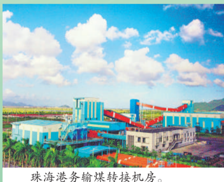
珠海港务输煤转接机房。
