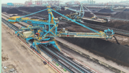
珠海港堆场正在进行堆料作业。
