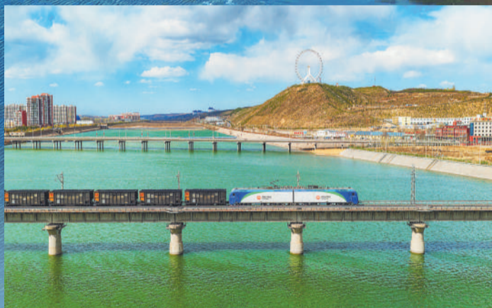
包神铁路神东大桥上运行的保供列车。李尚昆 摄
