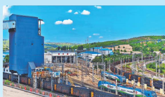
新朔铁路点岱沟装车站正在进行装车作业。薛培刚摄
