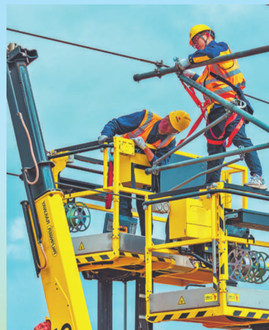
供电专业职工正在利用平台轨道车对接触网设备进行全面隐患排查。
