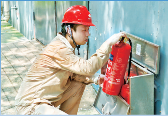
▲ 李森正在检查消防器材。
