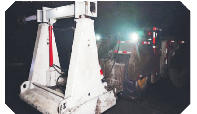
胶带上带面铺设专用装置。
