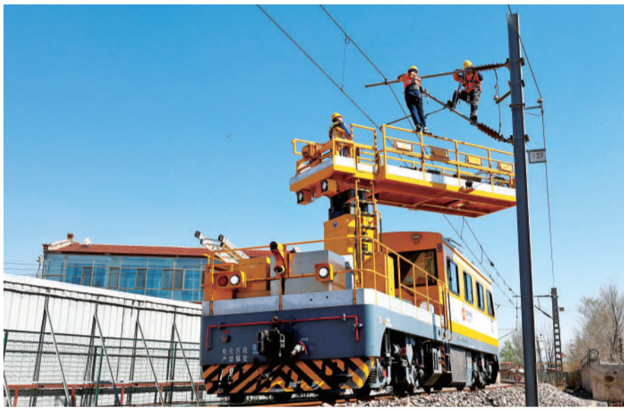
工作人员添乘巡视设备隐患。
