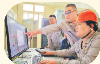
班组成员正在查验DCS系统运行逻辑。
