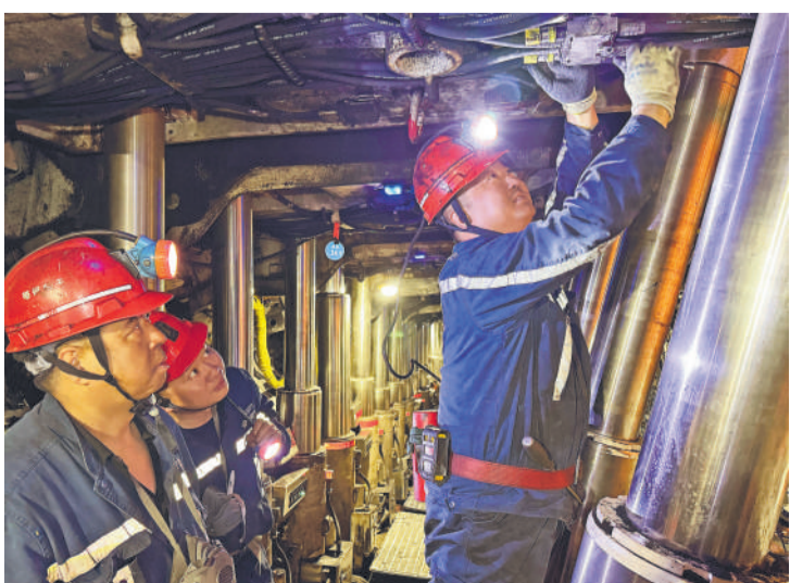
班组成员正在小心翼翼地更换液管。
