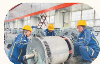
班组成员正在修复故障电机。
