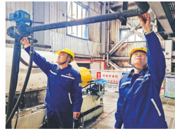
技术人员现场测量管路参数。
