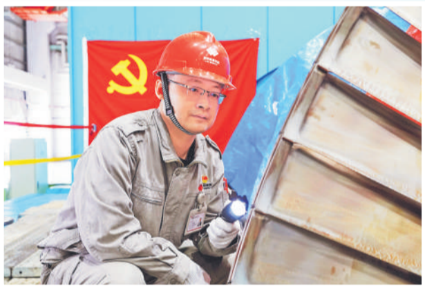
孙哲在5号机组检修现场检查汽轮机叶片磨损情况。
