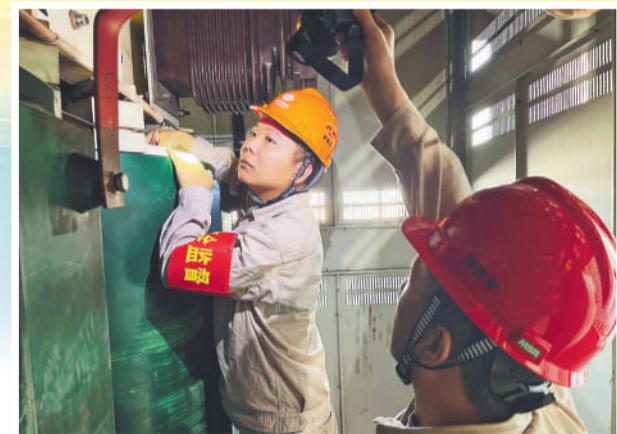
闻瑞士（左一）在铜陵电厂生产现场安装变压器温度传感器。
