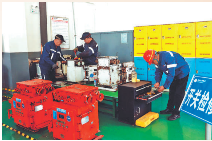
机修车间检修人员正在检修开关、保护器。
