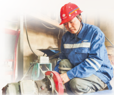
黄德义在检修通风设备。
