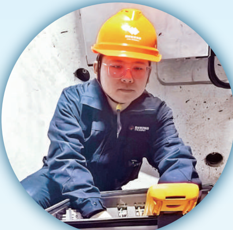
该小组成员正在对风机变桨系统进行检查。
