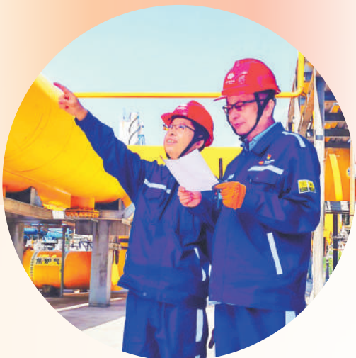
▲国庆假期，焦化西来峰甲醇厂生产车间党员与技术人员坚守一线，对照图纸现场排查焦炉气管线，逐项核对设备工况，排查安全隐患，以严谨细致的巡检，筑牢装置安全防线，保障节日期间生产平稳有序。 通讯员 刘额尔敦 摄
