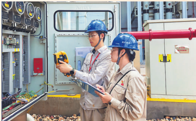
▲安徽合肥电厂检修人员运用红外热成像仪开展隐患排查，对电气设备接头、端子等易发热重点部位逐项测温检测。国庆期间，该厂加大巡检力度，提高测温频次，做到隐患早发现、早处置，切实守牢设备安全底线，以“零隐患”状态迎接国庆保供大考。 通讯员 阮露 摄
