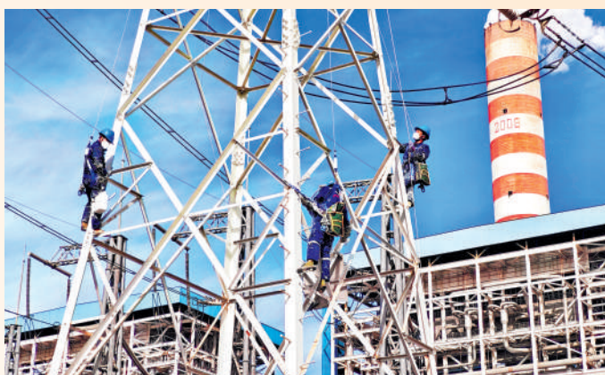
▲国庆期间，国电电力绥中公司职工坚守生产一线，统筹抓实2号机组A修攻坚与运行机组安全防护，严格落实现场监护、设备巡检、风险排查各项举措，保证节日期间能源稳定供应。 通讯员 韩兴华 摄
