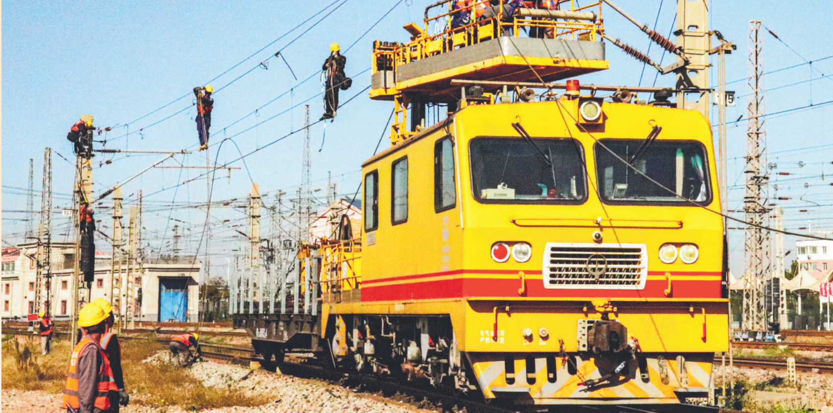
▲10月6日，朔黄铁路肃宁公司黄骅港站供电工队利用天窗点开展接触网换线施工作业。该站科学统筹节日期间运输与施工，精准铺排施工计划，最大程度提高天窗利用率，为“保供保目标、百日大会战”专项工作夯实设备安全基础。 通讯员 金文梁 摄
